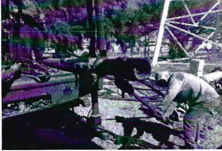
14/02/2021 INSTALACIÓN DE EQUIPO DE BOMBEO POZO No. 58, ZOOLOGICO, 19 1/2 TRAMOS DE 8", CON VALVULA CHECK DE 8"
