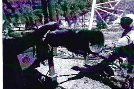
14/02/2021 INSTALACIÓN DE EQUIPO DE BOMBEO POZO No. 58, ZOOLOGICO, 19 1/2 TRAMOS DE 8", CON VALVULA CHECK DE 8"
