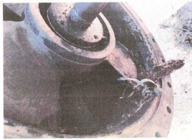
Limpieza de bomba propela del C-34 camino al carrizalito, la maniobra se realizó el día de ayer. MARTES 9 DE ABRIL
