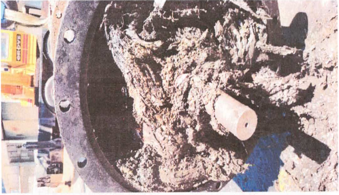
Maniobra instalación y/o desinstalación de equipo de bombeo Para realizar limpieza de bomba propela B5 del C-23. VIERNES 05 DE ABRIL de 2024
