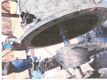
Limpieza de bomba propela del C-34 camino al carrizalito, la maniobra se realizó el día de ayer. MARTES 9 DE ABRIL
