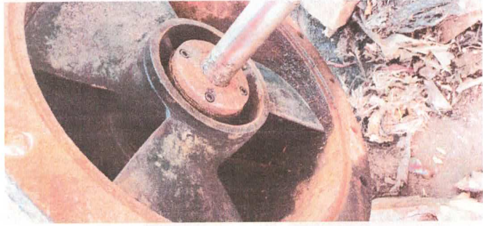
Maniobra instalación y/o desinstalación de equipo de bombeo Para realizar limpieza de bomba propela B5 del C-23. VIERNES 05 DE ABRIL de 2024
