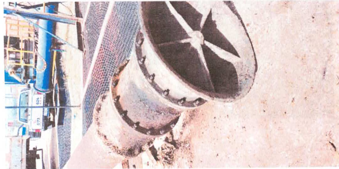
Maniobra instalación y/o desinstalación de equipo de bombeo Para realizar limpieza de bomba propela B5 del C-23. VIERNES 05 DE ABRIL de 2024
