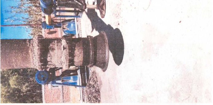
Maniobra instalación y/o desinstalación de equipo de bombeo Para realizar limpieza de bomba propela B5 del C-23. VIERNES 05 DE ABRIL de 2024
