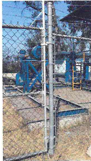
Pozo 103 (Alineación de portón de acceso y colocación de pasadores, instalación de luminaria)
