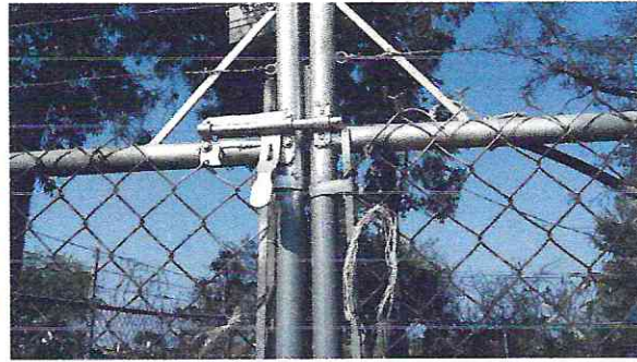
Cárcamo 24 (Alineación de portón de acceso y colocación de pasadores)
