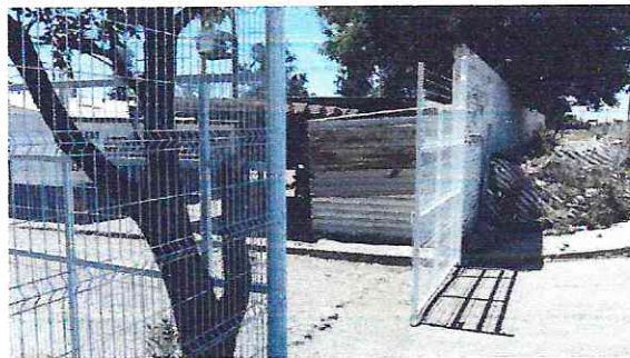
PORTÓN DE ACCESO COLOCADO
